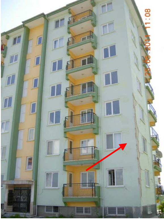
Şekil 63: 7 katlı dikdörtgen binadaki hasar, kolon paspayının dökülmesi, yaygın dolgu duvarı çatlağı
