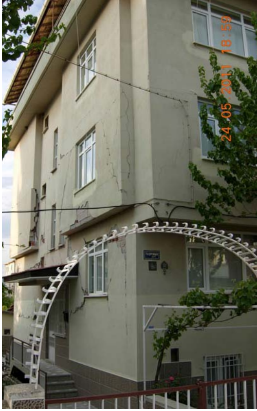
Şekil 61: Dolgu duvarı hasarı ve yapısal eleman üzerindeki sıvaların dökülmesi - önden ve yandan görünüş
