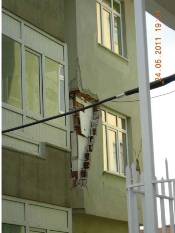
Şekil 62: Dış dolgu duvarlarda hasar
