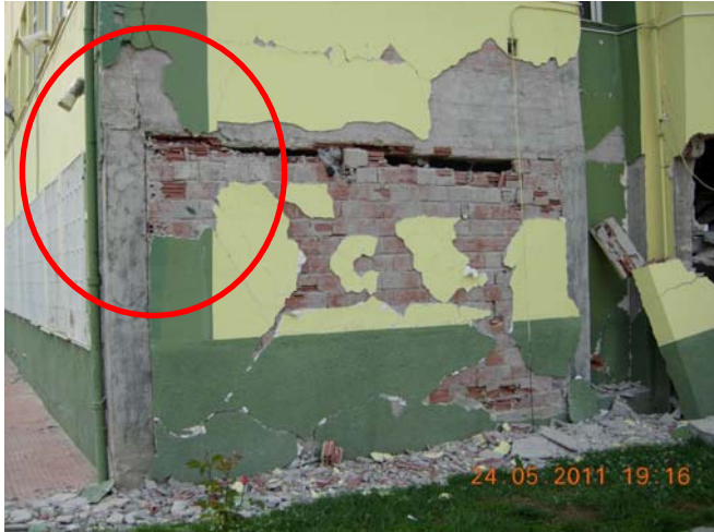
Şekil 74: Okul binasında, kolon-kiriş birleşim bölgesinde hasar
