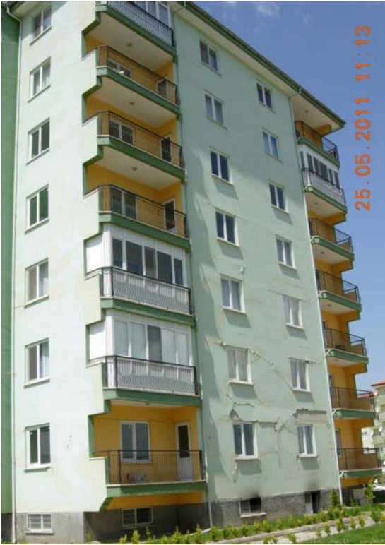
Şekil 64: 7 katlı dikdörtgen binada, orta yapısal olmayan hasar
