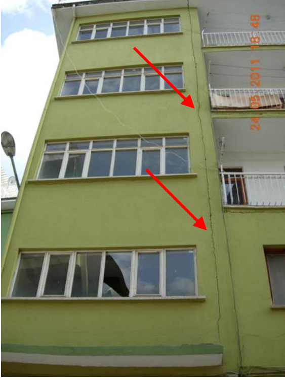
Şekil 55: Yıkılan binanın karşısındaki bina-kolonda tabandan çatıya kadar oluşan çatlak
