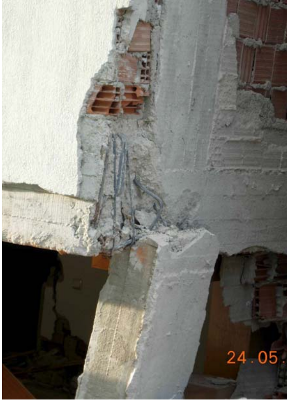
Şekil 48: Yıkılan binanın zemin kat güney-doğu köşe kolonu
