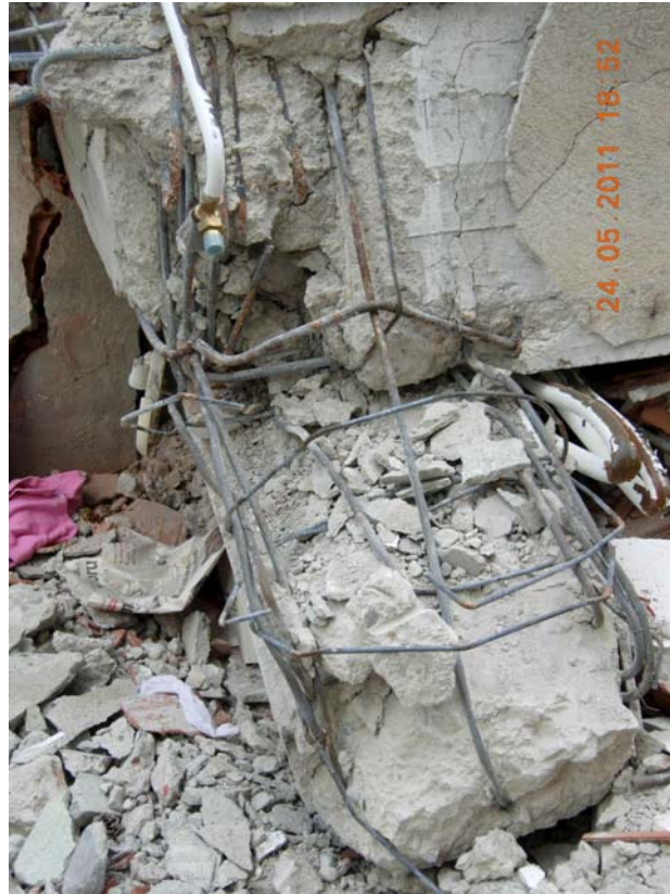
Şekil 51: Kuzey-batı kolonunda, kolon-kiriş birleşim bölgesi detayı
