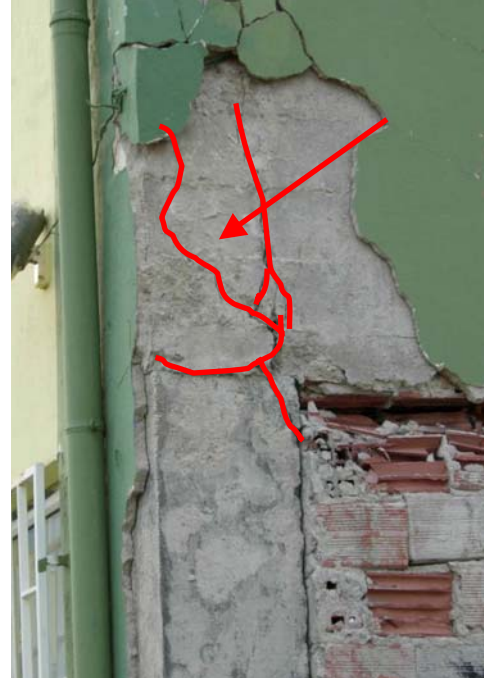
Şekil 74: Okul binasında, kolon-kiriş birleşim bölgesinde hasar
