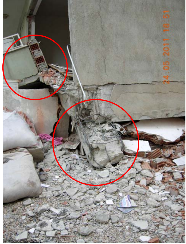
Şekil 50: Yıkılan binanın zemin kat kuzey-batı köşe kolonu
