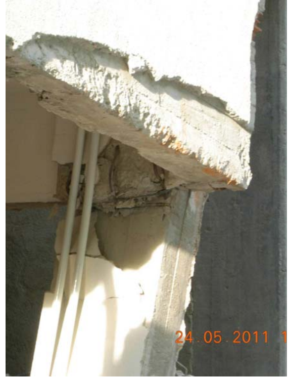
Şekil 48: Yıkılan binanın zemin kat güney-doğu köşe kolonu
