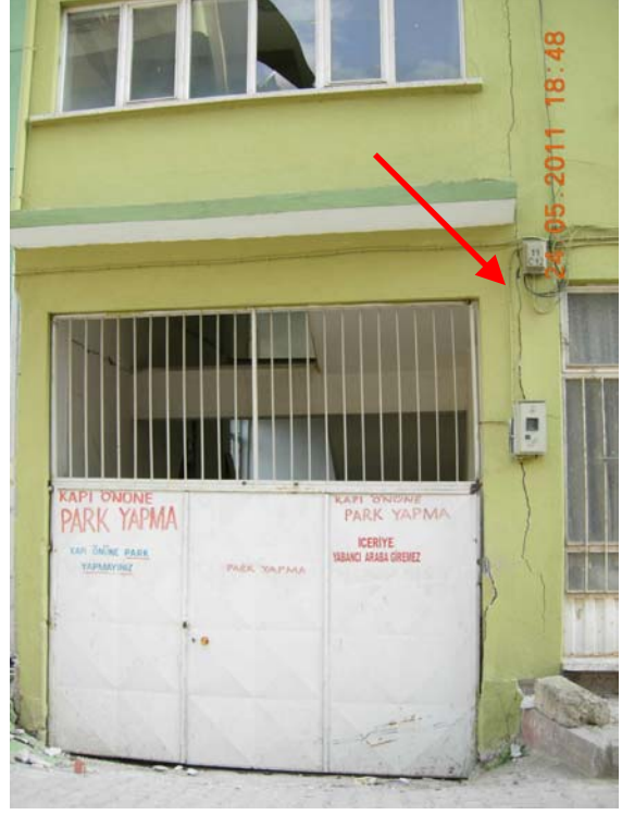
Şekil 55: Yıkılan binanın karşısındaki bina-kolonda tabandan çatıya kadar oluşan çatlak
