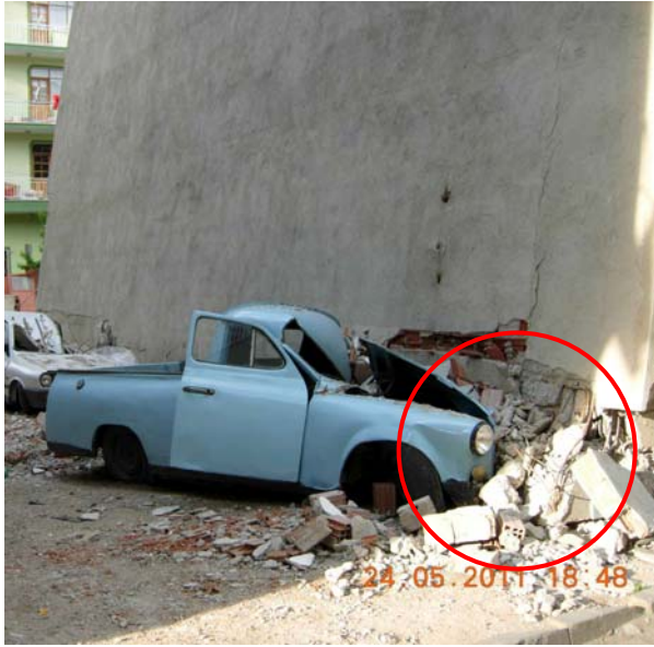
Şekil 49: Yıkılan binanın zemin kat güney-batı köşe kolonu
