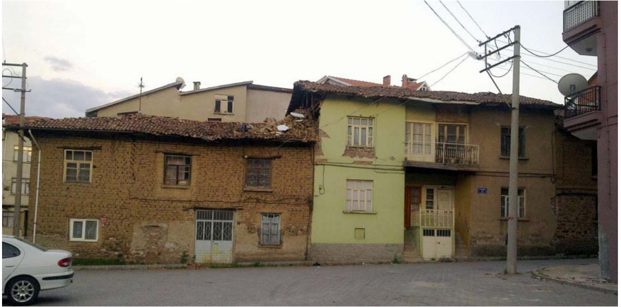
Şekil 40: 2 katlı kerpiç binalar - 2
