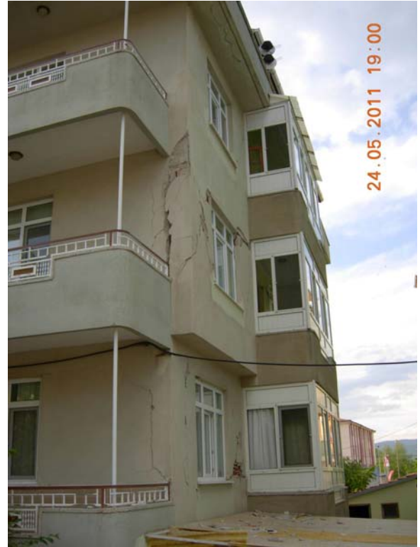
Şekil 62: Dış dolgu duvarlarda hasar
