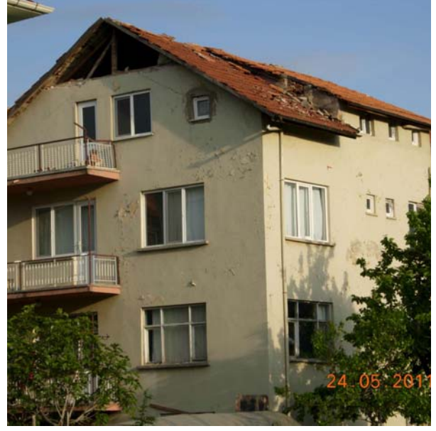
Şekil 59: Binalarda çatı hasarı
