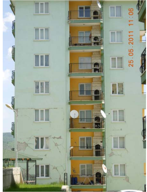
Şekil 64: 7 katlı dikdörtgen binada, orta yapısal olmayan hasar
