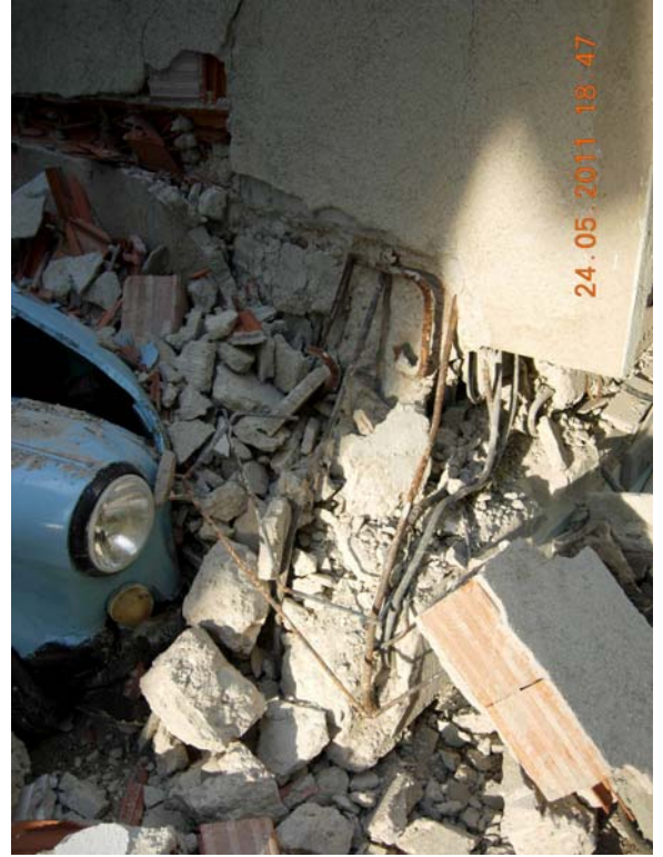
Şekil 49: Yıkılan binanın zemin kat güney-batı köşe kolonu
