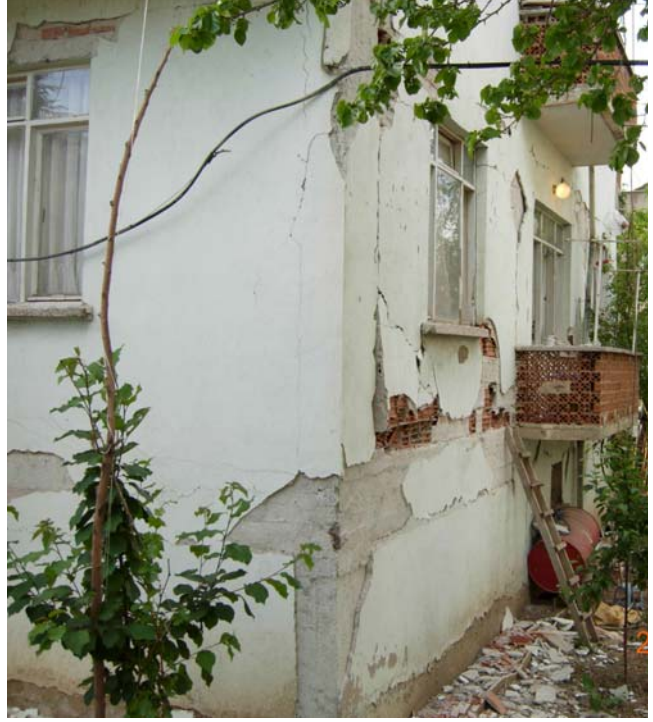
Şekil 61: Dolgu duvarı hasarı ve yapısal eleman üzerindeki sıvaların dökülmesi - önden ve yandan görünüş
