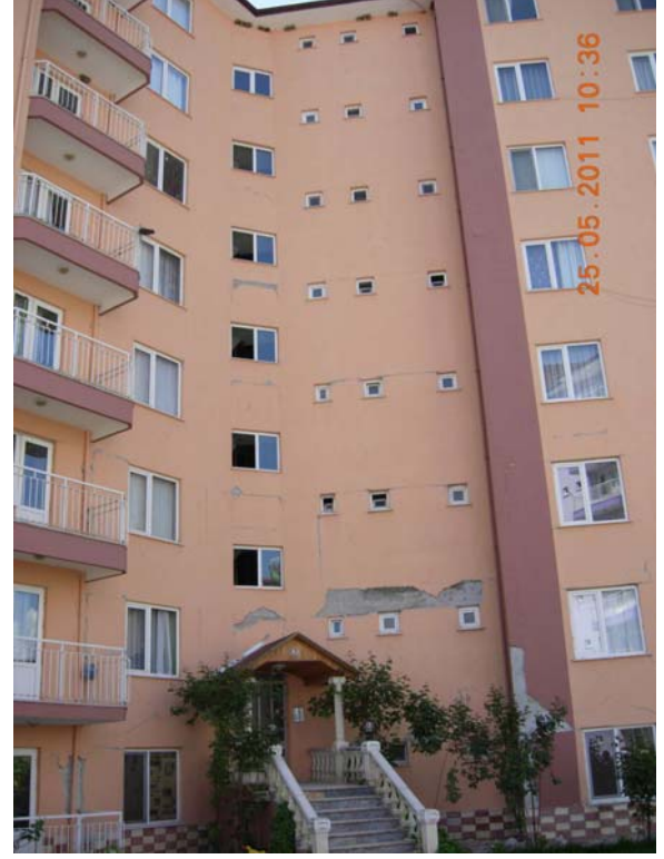
Şekil 65: 8 katlı yıldız bloklarda, orta yapısal olmayan hasar
