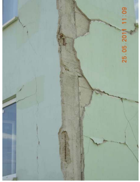
Şekil 63: 7 katlı dikdörtgen binadaki hasar, kolon paspayının dökülmesi, yaygın dolgu duvarı çatlağı
