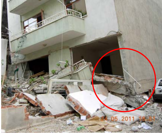
Şekil 50: Yıkılan binanın zemin kat kuzey-batı köşe kolonu
